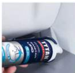
Aplicare de la bază și din interior
